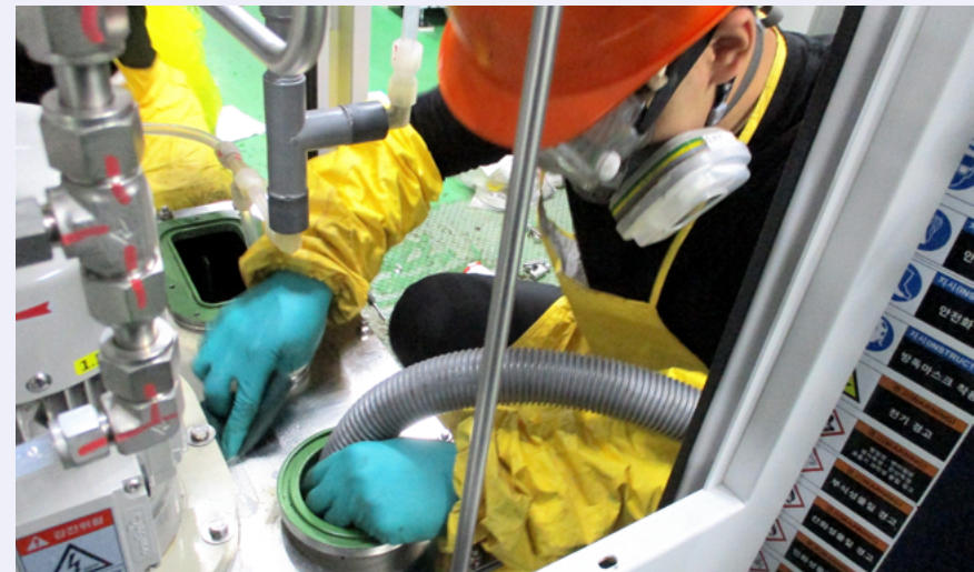
스크러버 체임버 내부 예방정비작업
